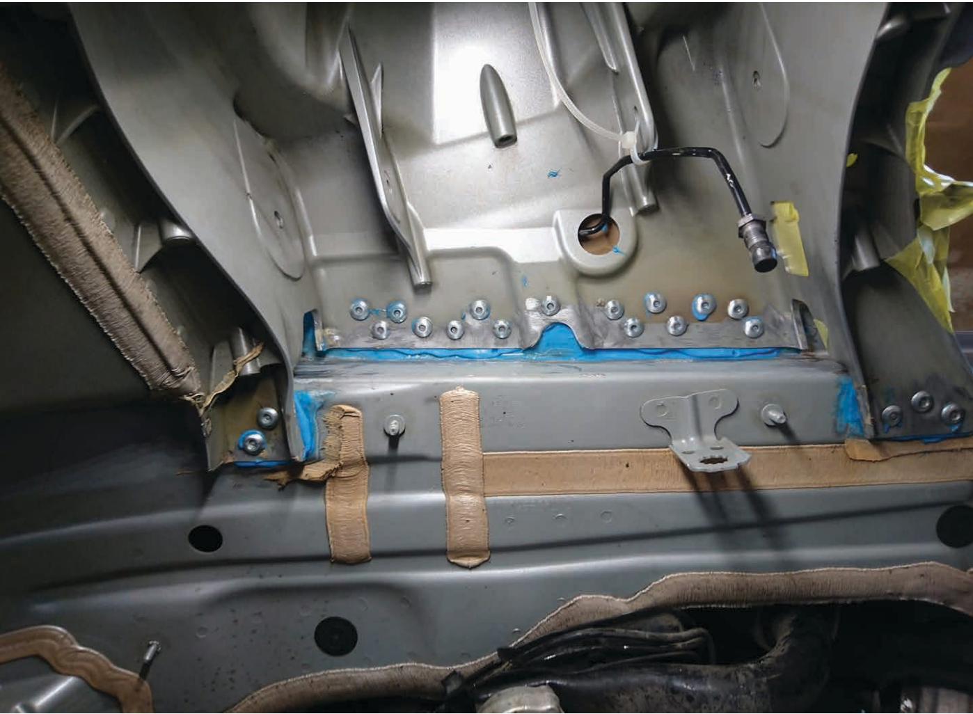
Fot. Nitowanie podczas wymiany elementu. (BR)
