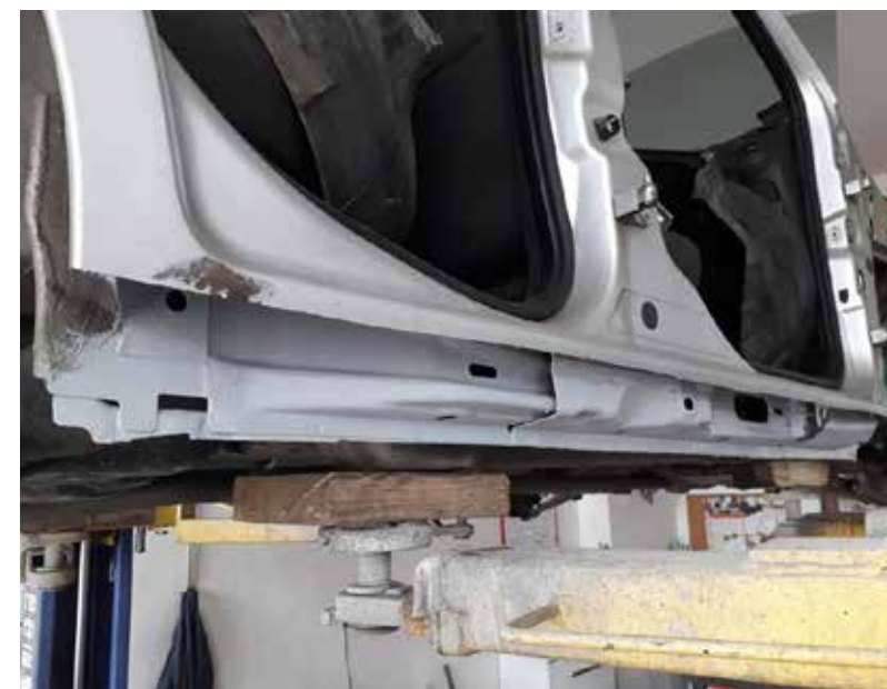
D. Po zabezpieczeniu antykorozyjnym podkładem epoksydowym wewnątrz profilu.
