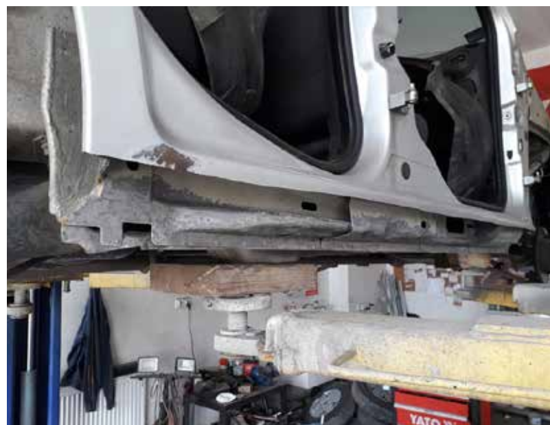
C. Po usunięciu mechanicznie korozji wewnątrz profilu.
