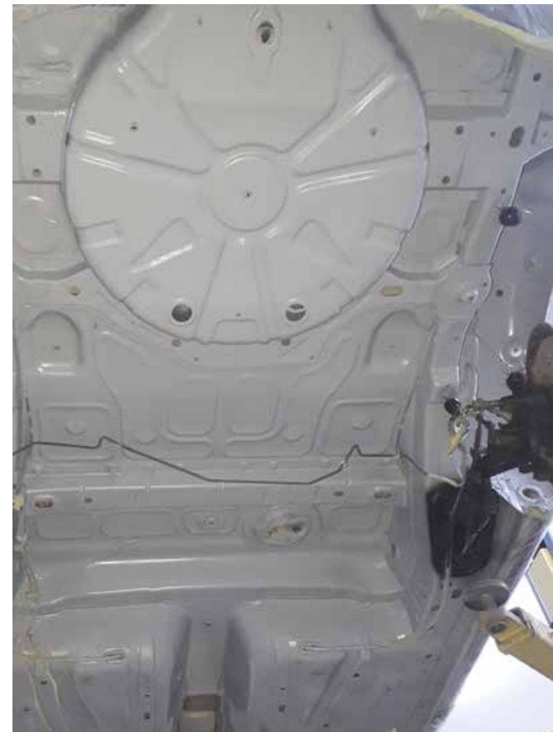
Fot. 7. Zabezpieczenie za pomocą podkładu epoksydowego NOVOL PROTECT 360. (Iron Garage Jeleśnia)
