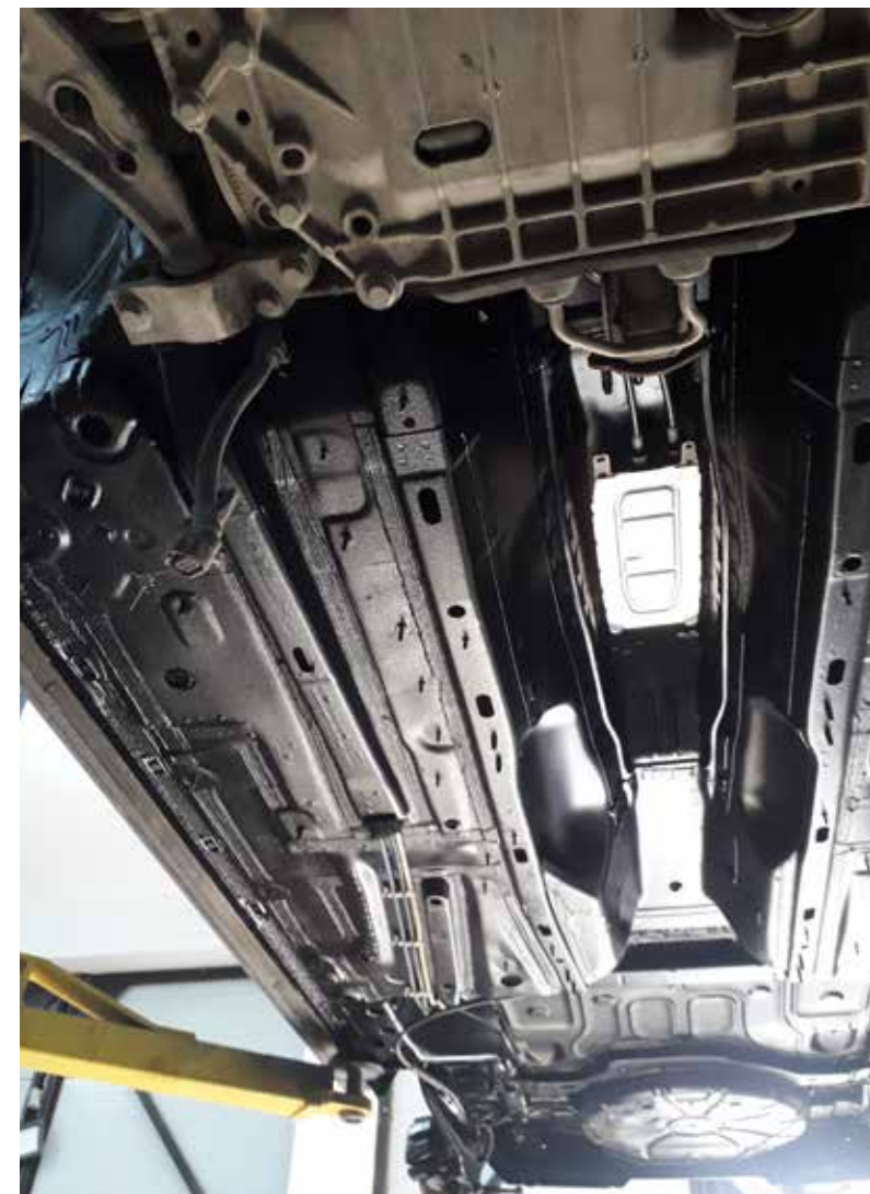
Fot. 10. Specjalistyczna powłoka ochronna COBRA NOVOL zaaplikowana po zabezpieczeniu antykorozyjnym. (Iron Garage Jeleśnia)
